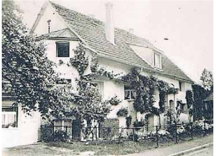
Das aus der früheren Nikolauskapelle in der Unteren Seestraße 97 hervorgegangene Gebäude im Bauzustand vor 1960.
