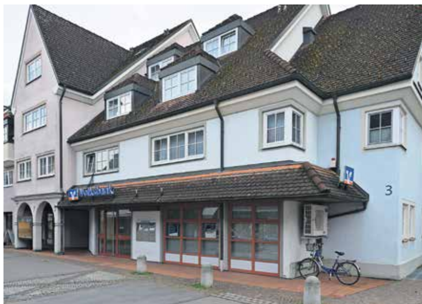
So präsentiert sich der westliche Teil des Gebäudeensemble ‚Seepalais‘ aktuell. Am Standort der ehemaligen Bäckerei unterhält die Volksbank Friedrichshafen-Tettngang Geschäftsräume.
